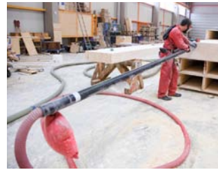
Einführen der Teleskopeinblaslanze in ein Holzelement
