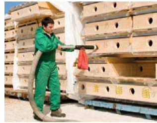
Befüllen von Holzelementen mittels Einblaslanze mit Staubsack
