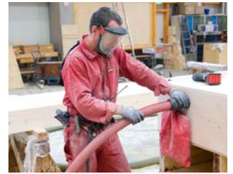
Die Teleskopeinblaslanze wird im Element auf die Nutzlänge ausgeschoben
