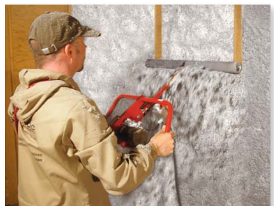
Planbürsten einer zuvor aufgesprühnten Wärmedämmung
