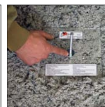
Dickenmessung einer offen aufgeblasenen Dämmung mit dem Dickenmesser
