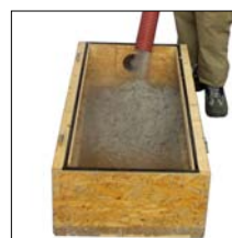
Offenes Aufblasen mit Schlauch
