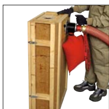
Verdichtetes Einblasen mit entlüfteter Drehdüse
