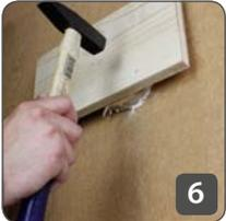
Bohrkern entsprechend der Markierung plan einsetzen. Mit Holzbrett und Hammer fixieren.
