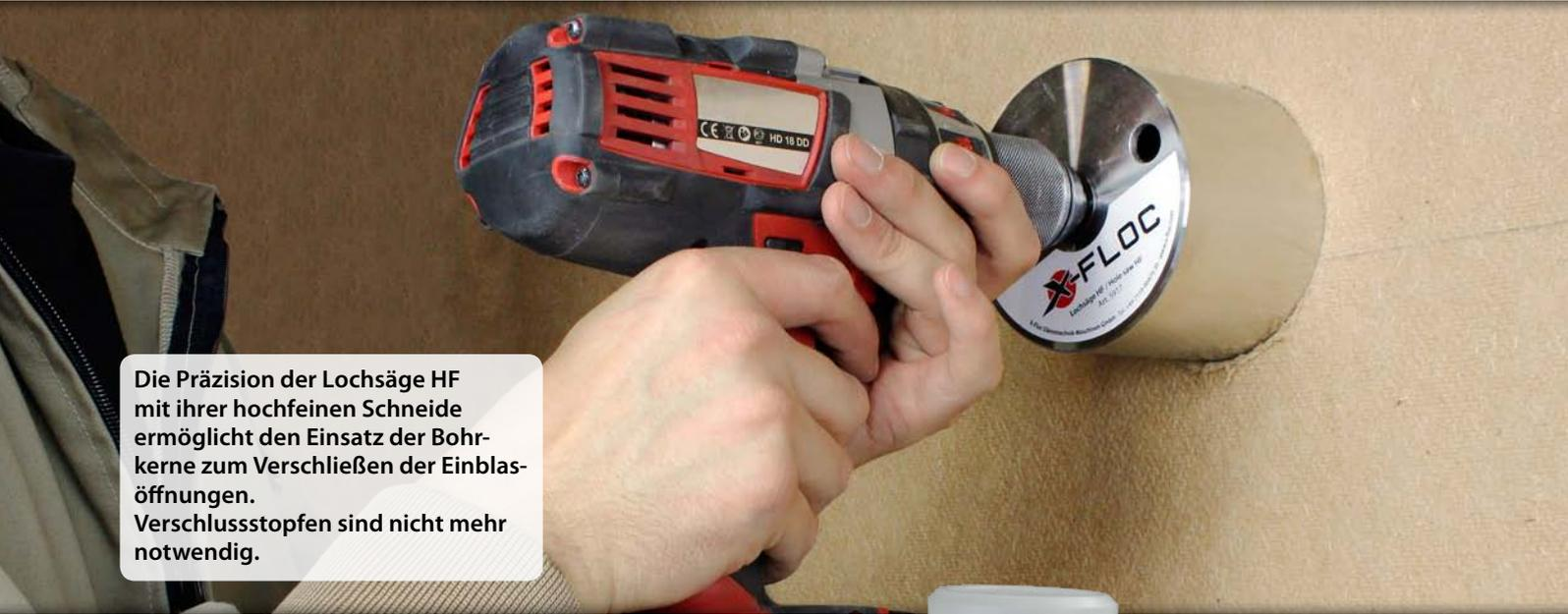
Die Präzision der Lochsäge HF mit ihrer hochfeinen Schneide ermöglicht den Einsatz der Bohrkern zum Verschließen der Einblasöffnungen. Verschlussstopfen sind nicht mehr notwendig.
