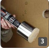
Den Bohrkern mit einem Stab durch die Öffnungen der Lochsäge herausschieben.
