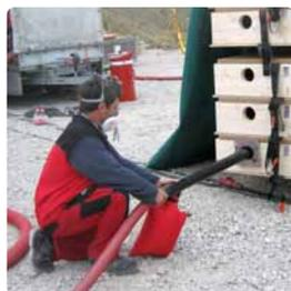
Einbläser mit Einblaslanze bei Elementbefüllung
