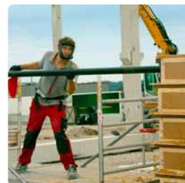
Einbläser mit Einblaslanze bei Elementbefüllung
