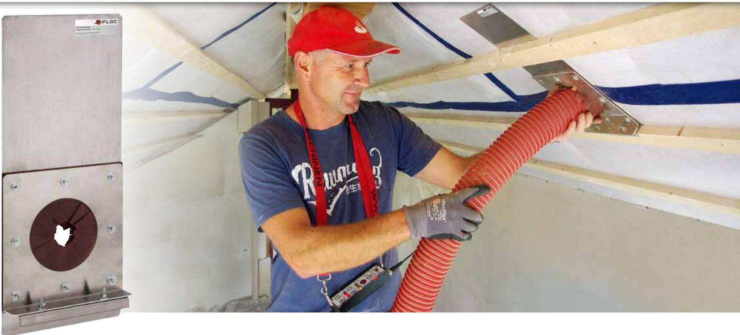
Die Einblasblende von X-Floc erleichtert das Einblasen von losen Dämmstoffen in Wand- und Deckenaufbauten und Schalungen mit Stützlattung, worauf Dampfbrems- und Luftdichtungsbahnen angebracht wurden.
